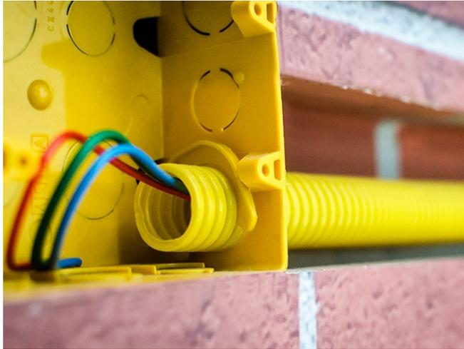
Instalação dos cabos de fibra óptica e cabos de rede utilizando tubulação embutida na parede com dimensões mínimas de 20mm, com curvatura mínima de 250mm e caixas de passagens a cada 30 metros.
